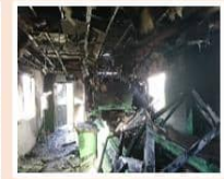
LiB発火が原因で 火災となった リサイクル工場設備
